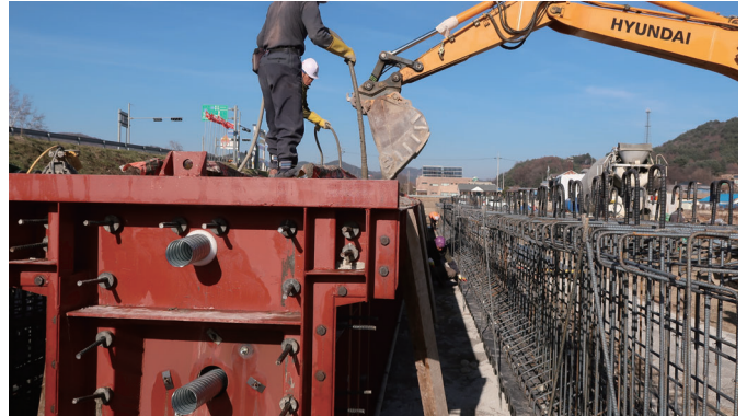
Step_5 콘크리트 타설
