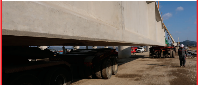
HFC 바닥 거푸집 적용으로 철판 조인부 시공 품질 확보
