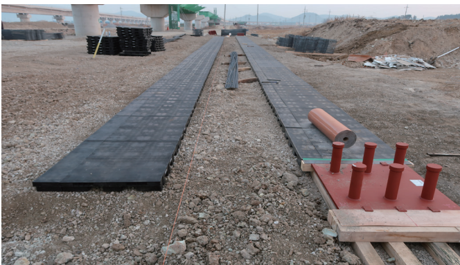
Step_3 HFC Form 설치
