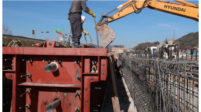
Step_5 Pour concrete & curing
